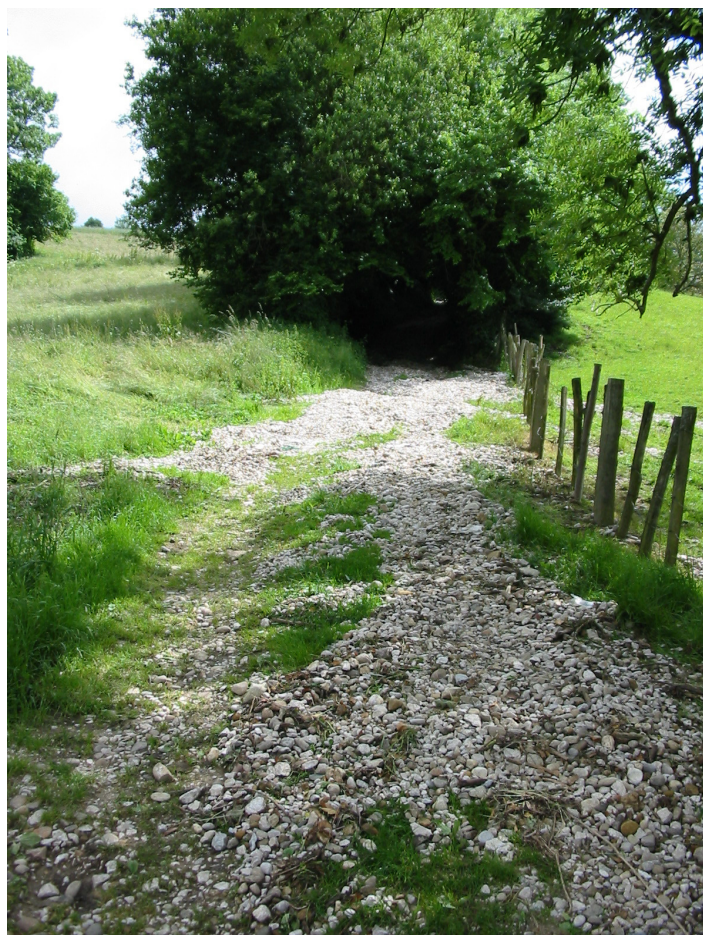
Ravinements sur le chemin de Sicaud (orage du 06/06/2002)
