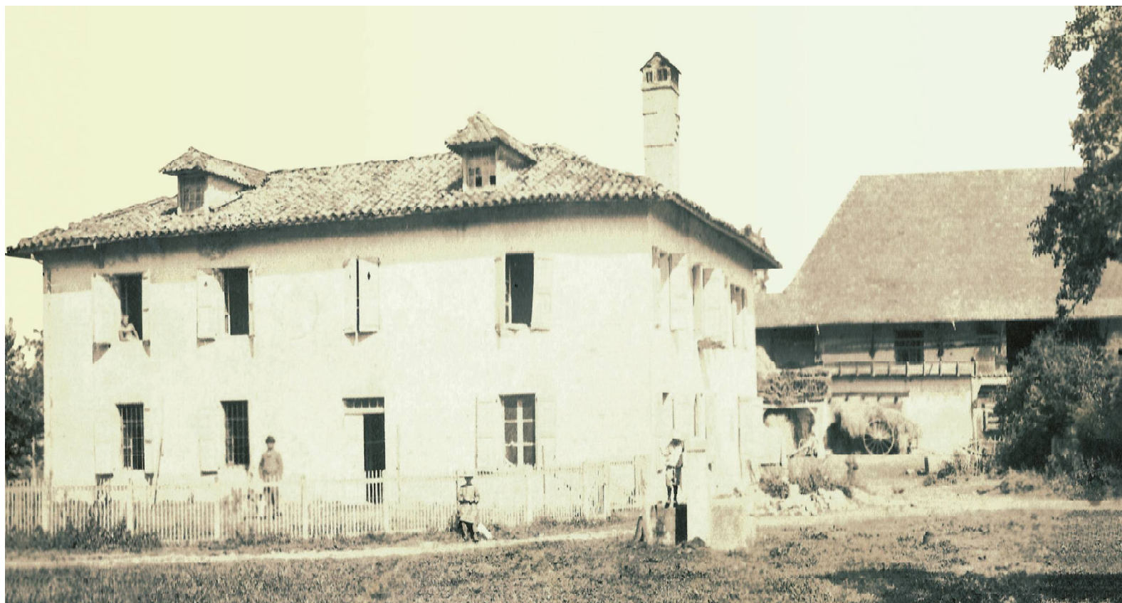
Photo de Joseph Apprin, vers 1900. Il s'agit de la maison du photographe, située au Jayet à Montferrat. Construite au début du XVIII e siècle, elle fut le rendez-vous de chasse du comte de Barral. Achetée par Laurent J.-P. Apprin, son secrétaire, le 24 mars 1784.
